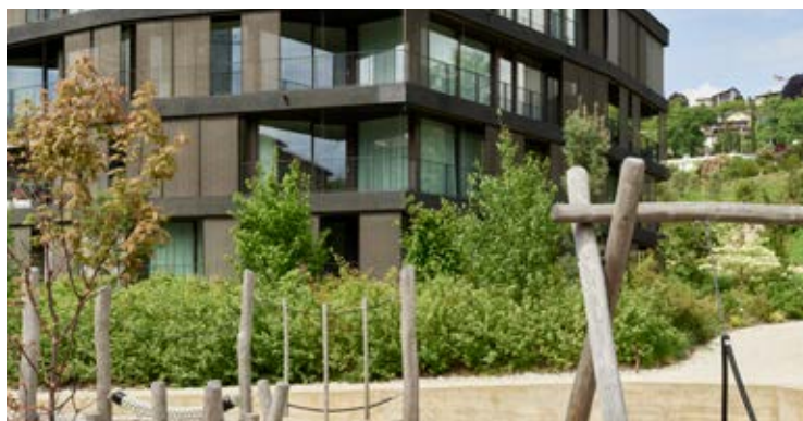
La résidence Parco Casarico a été conçue en incorporant de nombreux éléments de la ville éponge.
