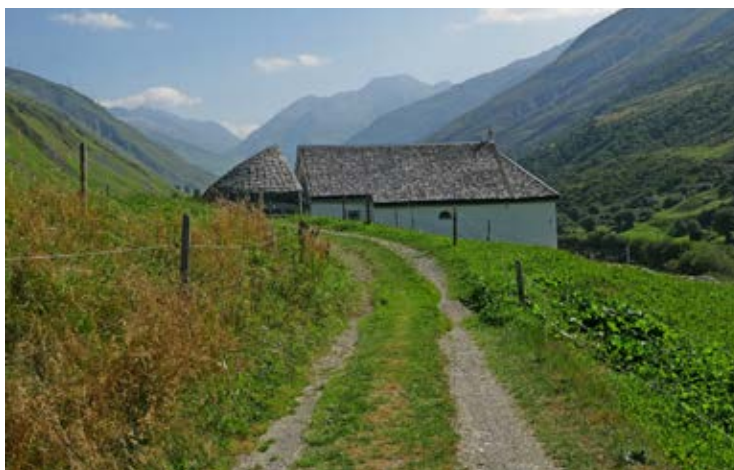
Un cuneo separatore protegge da oltre tre secoli la cappella sul Lieg, vicino a Realp (UR), dalle valanghe.
