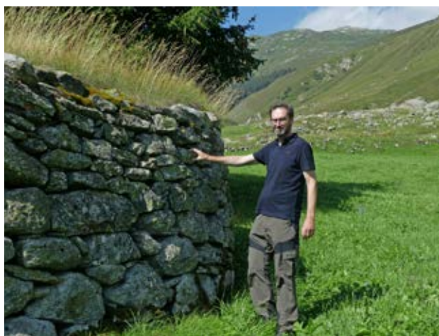
Ce mur de pierres sèches protège le hameau de Steinbergen; sur la photo, Thomas Brunner, conservateur des monuments historiques du canton d'Uri.
